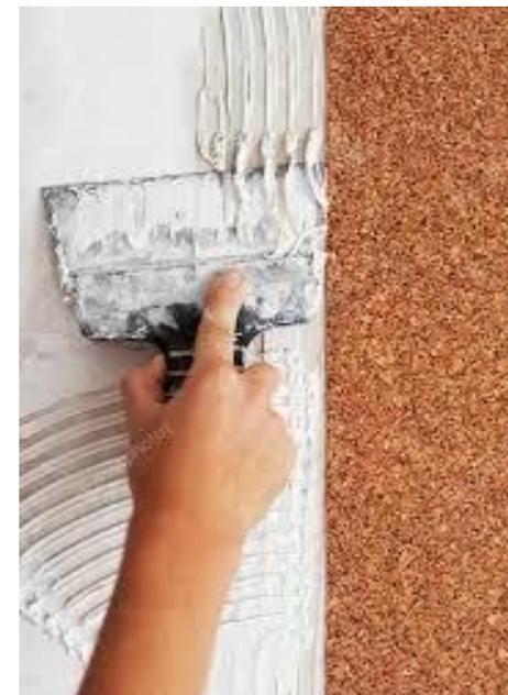
Para a colagem das molduras, aplicar cola apropriada para o efeito nas costas da moldura e, se necessário, na superfície.
