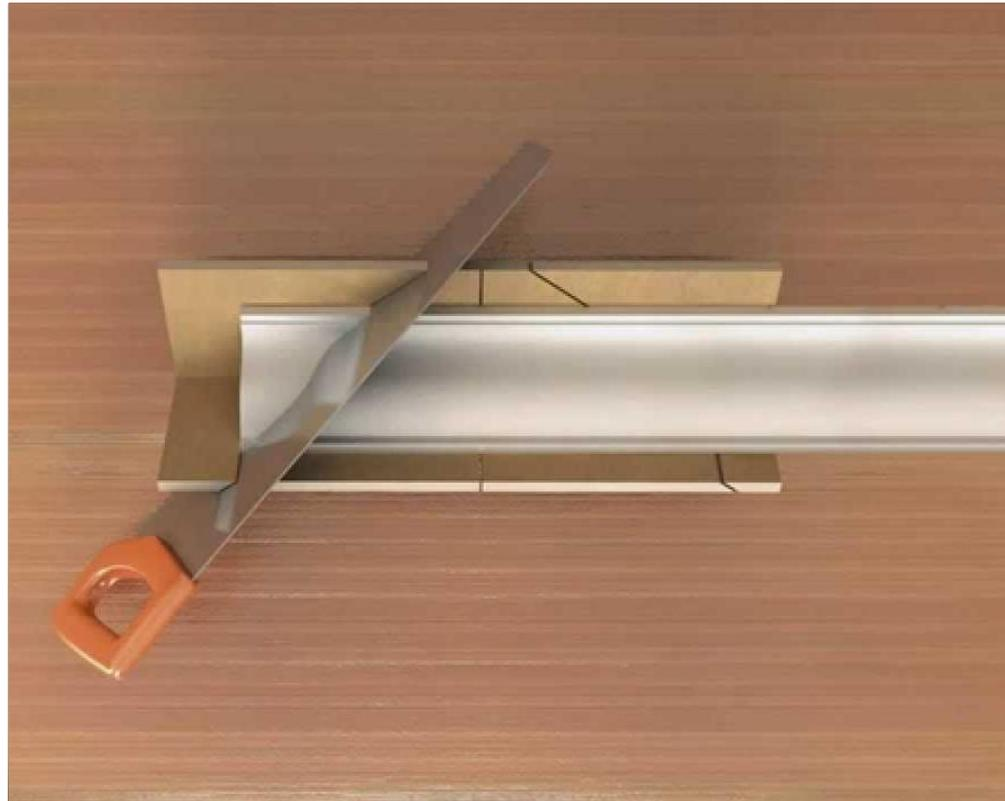
Com o apoio de um molde de corte de esquadria e um serrote, fazer o corte necessário para a aplicação da moldura.
